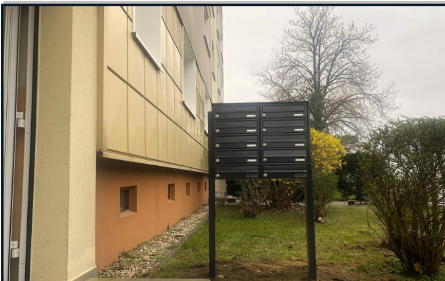
Nach und nach werden die Briefkästen außerhalb des Gebäudes verlegt.
