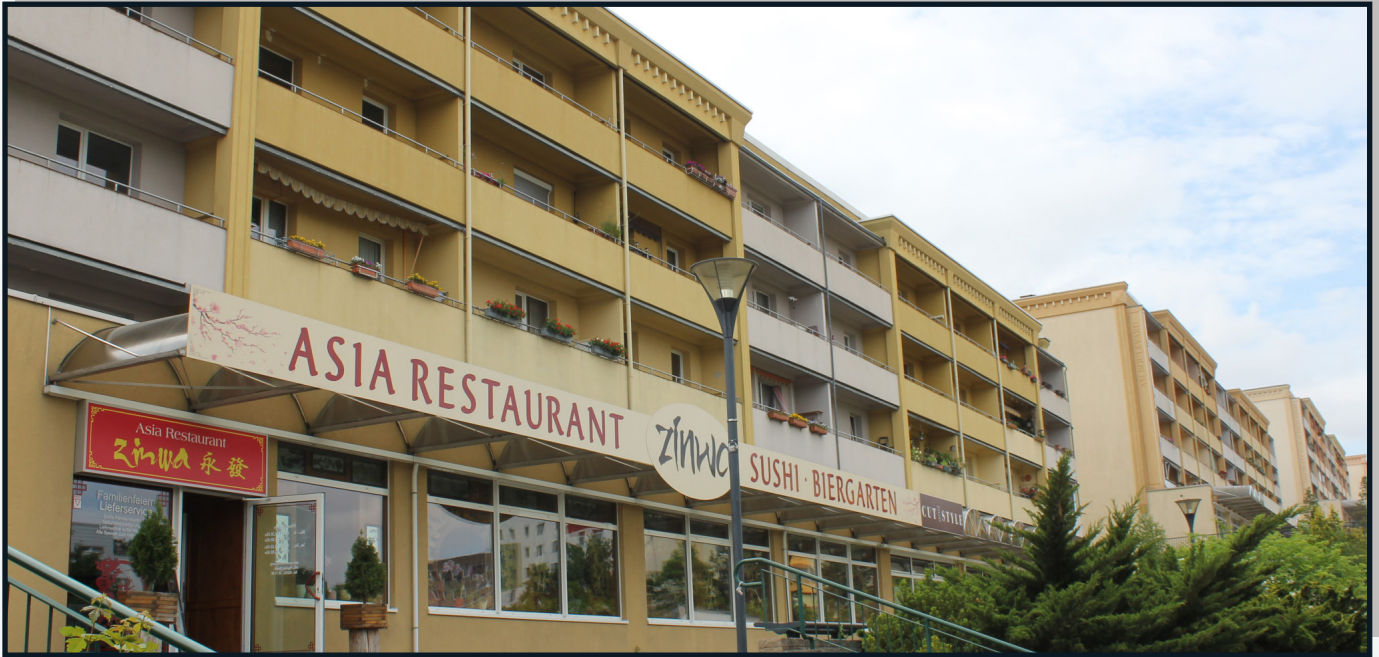
Fassaden am Boulevard werden gereinigt.
