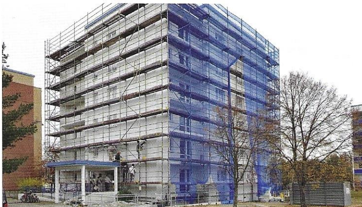
Das komplex sanierte Würfelhaus Am Freizeitpark 3 kurz vor der Fertigstellung.
