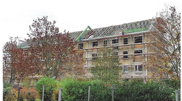
Görlitzer Straße 12–16 kurz vor dem Rückbau der beiden oberen Etagen.
