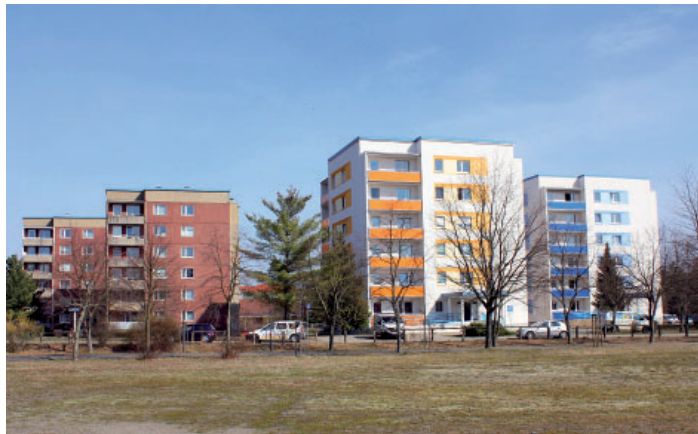
Das Gebäude Am Freizeitpark 3 wird energetisch saniert. Rechts davon die beiden bereits sanierten Würfelhäuser.
