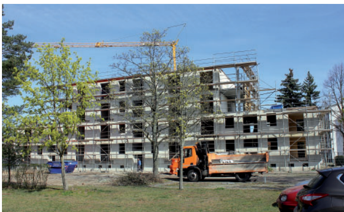
Humboldtstraße 2–6: mit 1,6 Millionen Euro das größte Bauvorhaben 2020.
