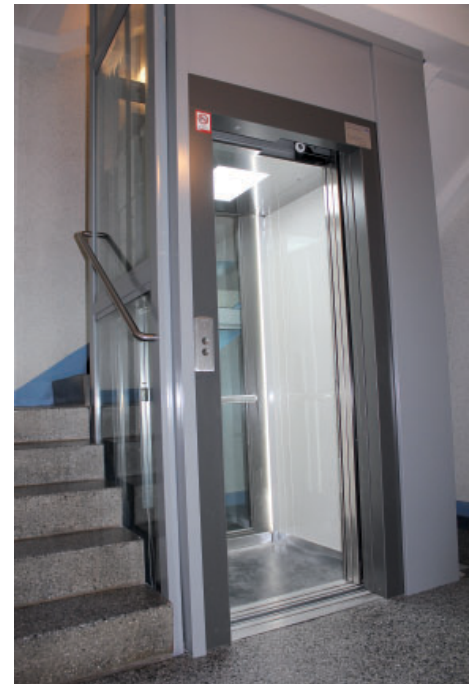
Dieser Fahrstuhl wurde im Vorjahr im Albert-Schweitzer-Ring 23 eingebaut.
